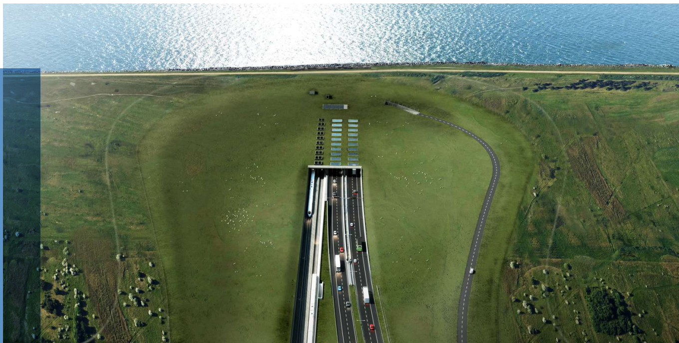
Portalområdet Rødbyhavn efter færdiggørelsen af tunnelen. Kilde: Femern A/S
